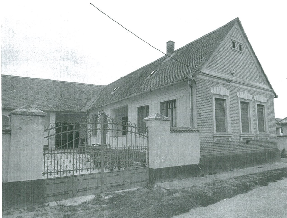
Karbantartott téglá oromfalas lakóház kovácsoltvas kerítés kapuval
